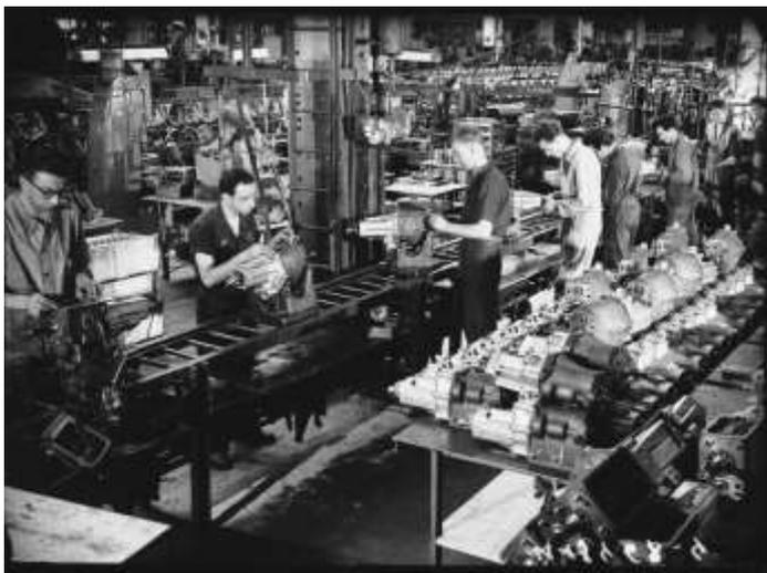
1-Chaîne de montage des boîtes de vitesses C.2., 1954
