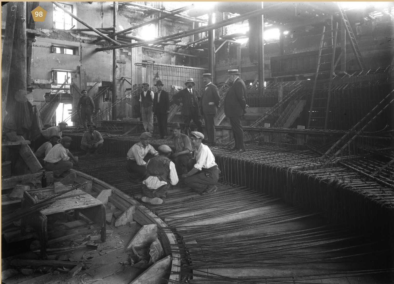
TRAVAUX DE CONSTRUCTION DES NOUVEAUX GRADINS DU THÉÂTRE EN BÉTON ARMÉ, ADTB 51 FI 88
