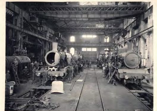
Montage des locomotives — Vue générale
