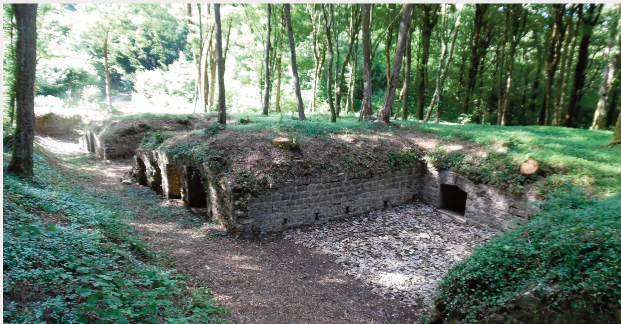
27 Photographie de la batterie du Bromont à Denney, récemment restaurée. Les niches au-devant des plates-formes abritent les munitions, celles situées le long du chemin, les artilleurs (Photographie J.C. Pereira).
