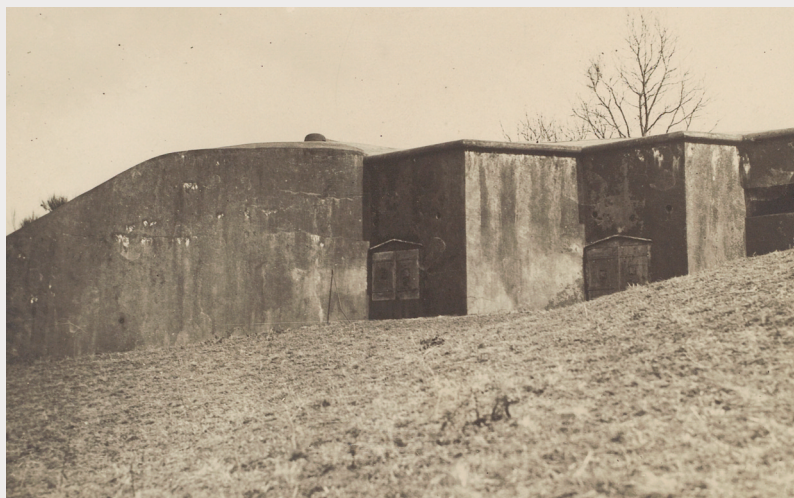
39 Casemate de Bourges au fort de Roppe. Deux canons de 75 mm sous casemate en béton remplacent à moindre coût une tourelle, lorsque c'est possible. Les embrasures sont ici protégées par des volets métalliques (coll. La contemporaine, VAL473/112)
