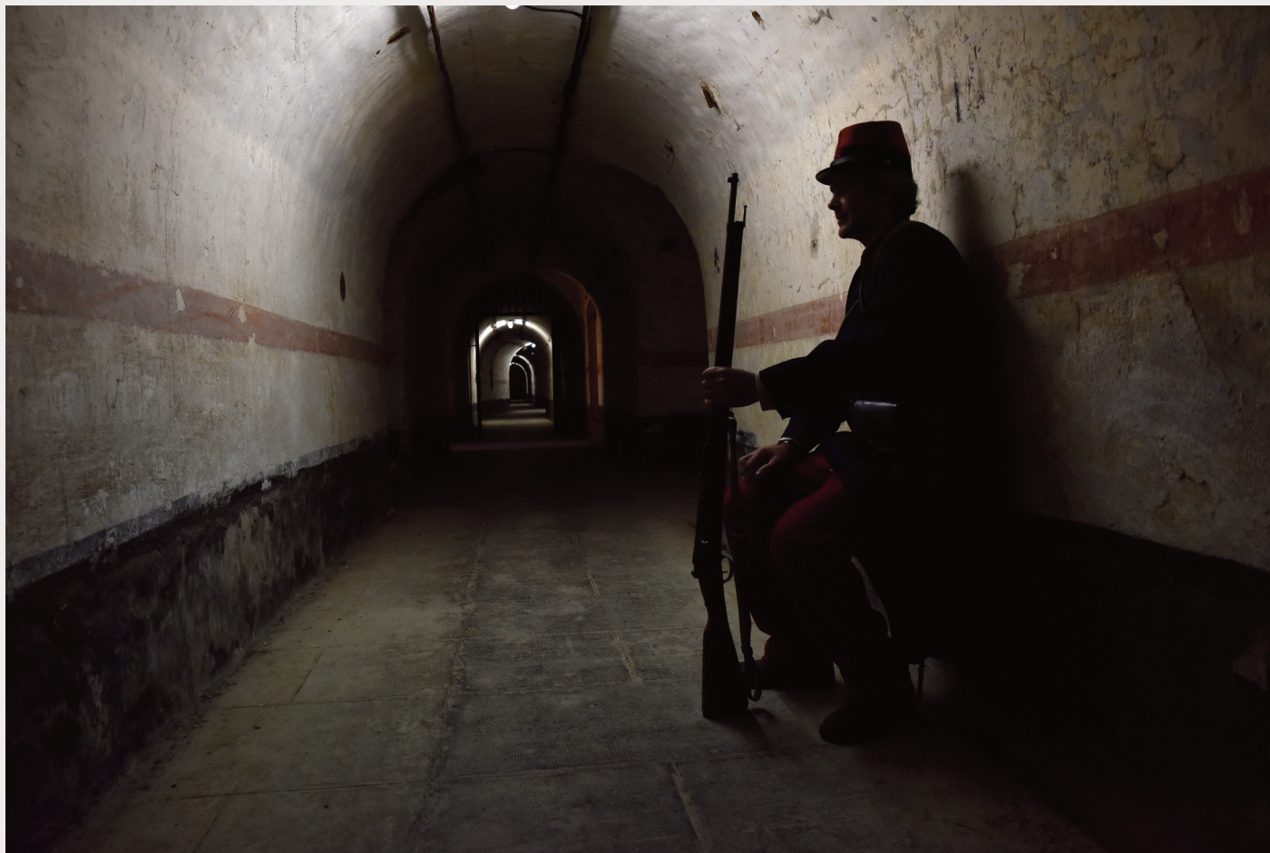
19 Un soldat se repose dans la gaine arrière de la caserne du fort de Bessoncourt reconstruite en béton. Les bandes rouges (d'époque), indiquent aux occupants que le local est à l'épreuve des bombardements (reconstitution de 2018, photographie J.F. Lami).
