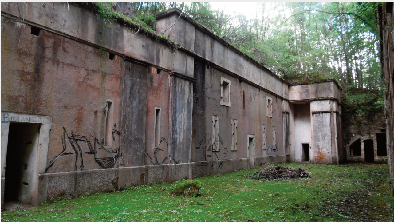
41 Cour du fort de Roppe, façade de l'aile de la caserne renforcée en béton armé en 1905-1907. Comme à Meroux, la façade bétonnée est rythmée par des pilastres engagés soutenant une corniche (photographie J.C. Pereira).
